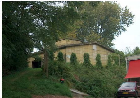
4.17. Locatie 9. Commandobunker luchtverdediging, 2005. (Herkomst: SB4 .)
