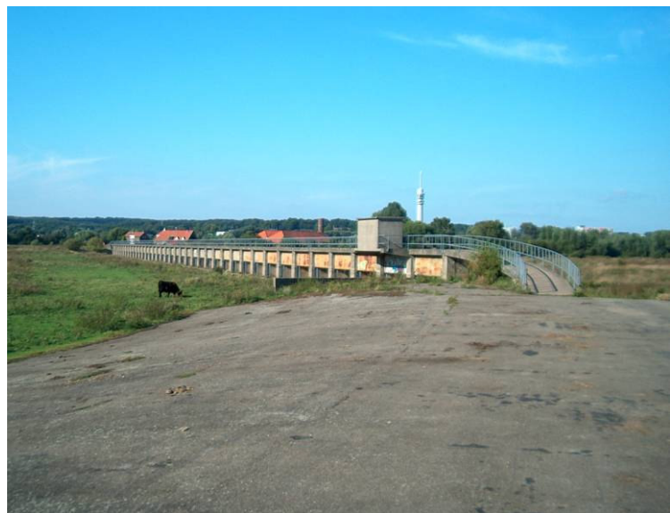
4.14. Locatie 8. Overstordijk met doorlaatsluis, 2005. (Herkomst: SB4 .)
