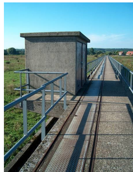
4.16. Locatie 8. Brug over doorlaatsluis, 2005. (Herkomst: SB4 .)
