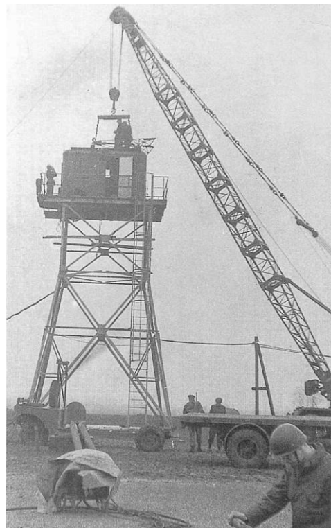
3.16. Radartoren in aanbouw ten zuiden van de Nederrijn. (Herkomst: YL.)
