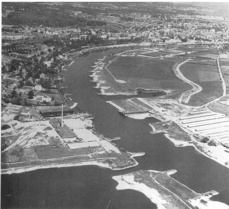
2.10. Het complex van de stuw in de Nederrijn. (Herkomst: YL.)
