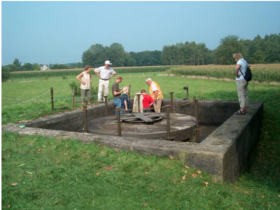
3.11. Betonnen bak met bemanningsonderkomen voor een vierlingmitrailleur, situatie bij Olst, 2005. (Herkomst: SB4.)
