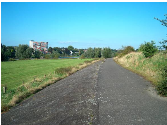
4.11. Locatie 6. Overstordijk direct langs de rivier, ter hoogte van de stuw, 2005. (Herkomst: SB4 .)
