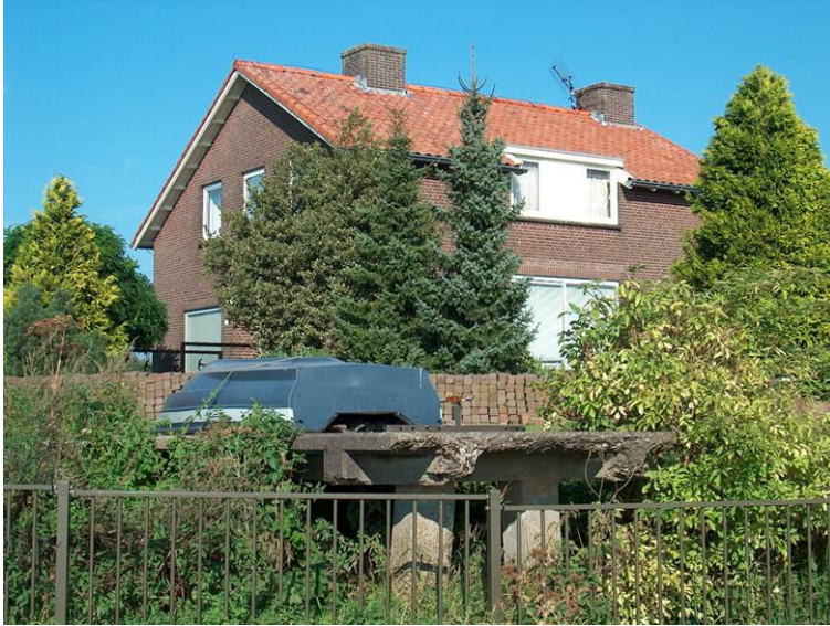
4.26. Locatie 24. Restant van betonnen loopbrug tussen steenfabrieksterrein en terp, 2005. (Herkomst: SB4 .)
