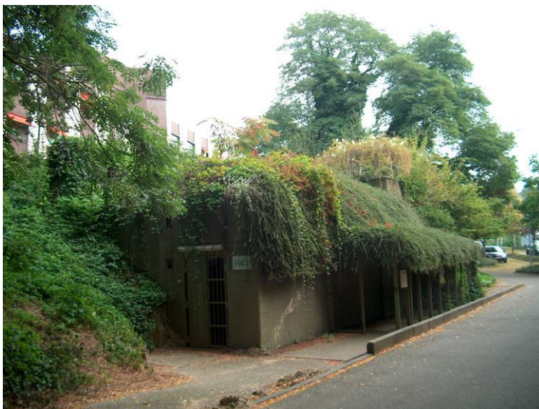
4.19. Locatie 10. Bataljons-commandobunker, 2005. (Herkomst: SB4 .)
