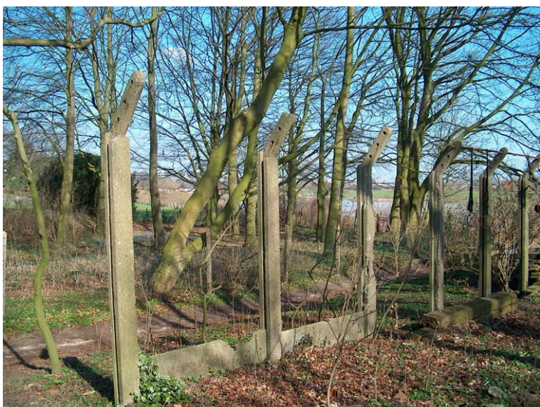
4.7. Locatie 2. Restant van betonnen schutting, 2005. (Herkomst: SB4.)
