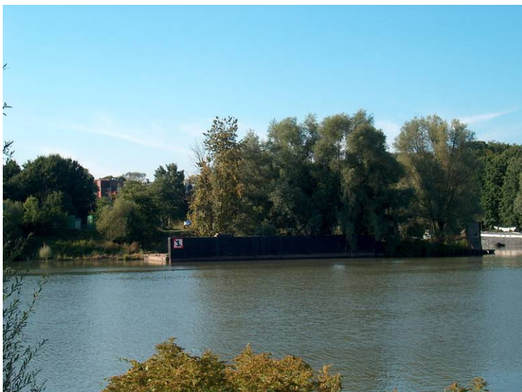
4.2. Locatie 1. Landhoofd aan de noordzijde van de rivier, gezien vanaf de overkant, 2005. (Herkomst: SB4.)
