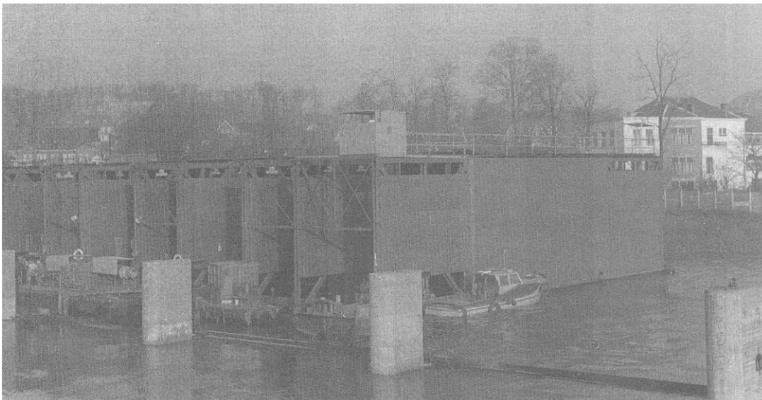
2.5. Het caisson in de berghaven van de Nederrijn. (Herkomst: DS)
