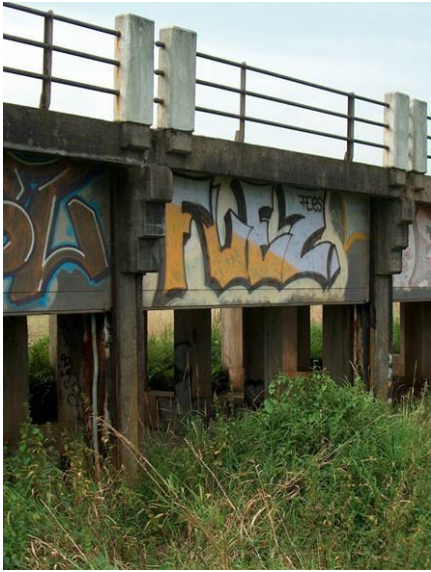
4.13. Locatie 7. Stalen schuifluiken in de doorlaatsluis, 2005. (Herkomst: SB4 .)
