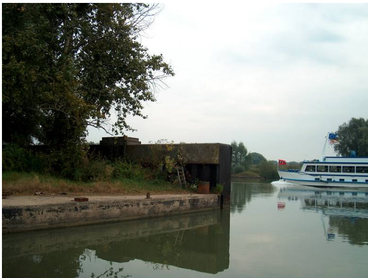
4.1. Locatie 1. Vloer van de sluis onder de doorlaatbrug en landhoofd aan de noordzijde van de rivier, 2005. (Herkomst: SB4.)
