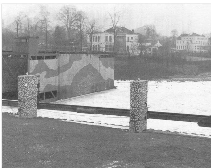
3.17. Caisson en meerpalen bij Arnhem geschilderd in camouflagekleuren; in verband met ijsgang zijn de camouflerende netten in het water tijdelijk verwijderd. (Herkomst: YL.)
