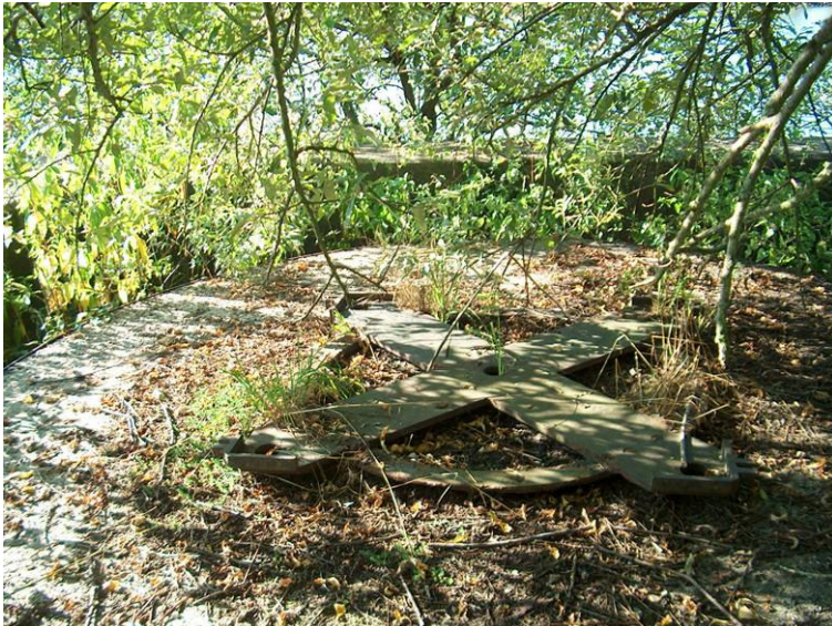
4.27. Locatie 25. Betonnen plateau als opstelplaats voor vierlingmitrailleur, 2005. (Herkomst: SB4 .)
