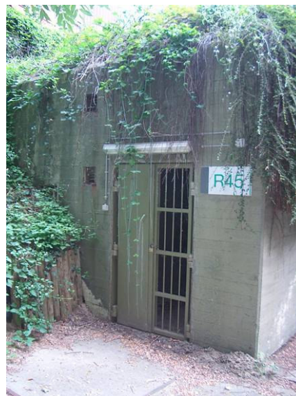
4.20. Locatie 10. Entree bataljons-commandobunker, 2005. (Herkomst: SB4 .)
