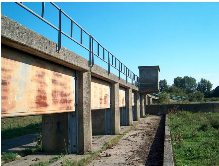
4.15. Locatie 8. Doorlaatsluis met stalen schuiven, 2005. (Herkomst: SB4 .)
