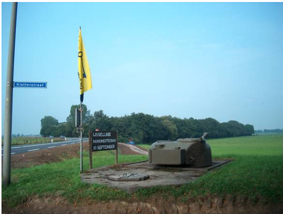
3.5. Tankkazemat in de vorm van een ingebetonde Shermantank, situatie bij Olst, 2005. (Herkomst: SB4.)
