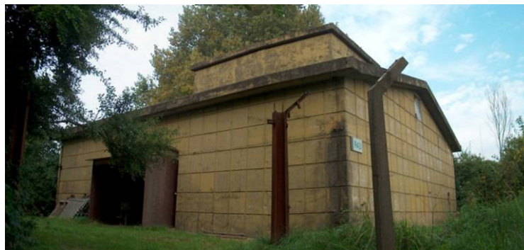
4.18. Locatie 9. Commandobunker luchtverdediging, 2005. (Herkomst: SB4 .)
